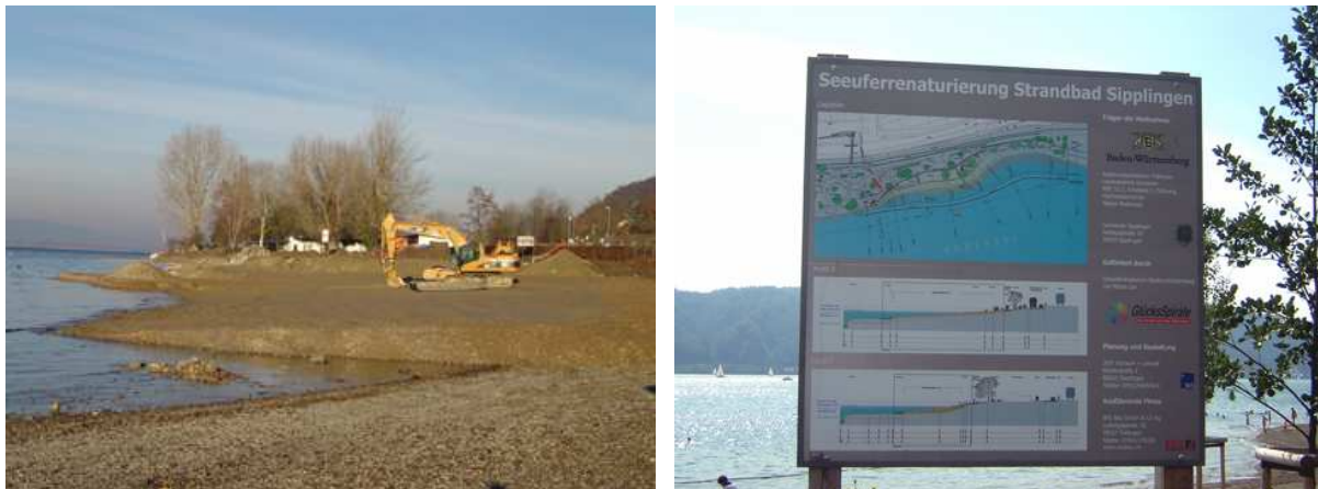
Abbildung 4: Überschüttung sublitoraler Lebensräume bei der als Seeuferrenaturierung deklarierten Sanierung und Erweiterung des Strandbads Sipplingen (linkes Foto am 16.02.2007 bei 394,66 m ü NN, d.h. 0,16 m über mNW).
