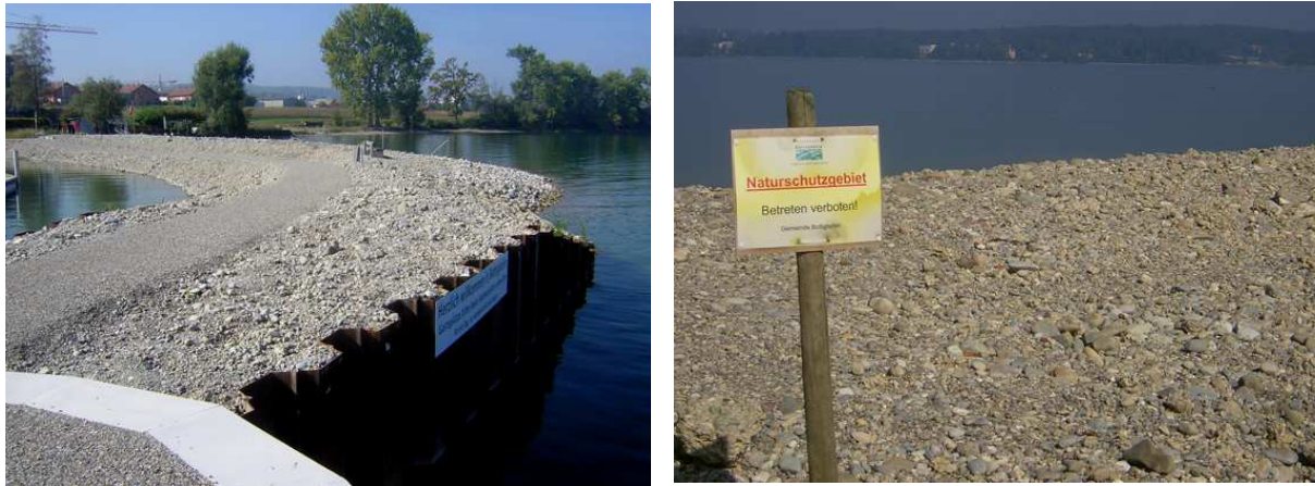
Abbildung 6: Uferrenaturierung in Bottighofen (CH, TG) am Obersee: Nach Ansicht der Planer musste die Hafenerweiterung und die Neuschaffung von Boots- und Liegeplätzen durch eine massive, bis auf rd. 398 m RPN (ca. 1,5 m über dem mHW) aufgeschüttete und etwa 25 m breite Mole geschützt werden; links – Übersicht, rechts – die Geröllschüttung wurde im Zuge des naturschutzrechtlichen Ausgleichs in ein Naturschutzgebiet der Gemeinde umgewandelt, – die zu schützende Natur liegt freilich in 3 m Tiefe unter der Schüttung (Fotos 21.09.2007, W. Ostendorf).
