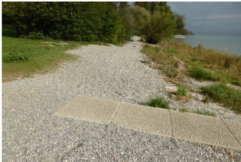
Abb. 4: Hagnau Strandbad-Mitte: eine der beiden Betonrampen in den See (Blick nach Osten: auf dem wieder freigelegten Ufer mit gröberem Material hat sich wieder Ufervegetation entwickelt) (13.09.2023; Pegel Konstanz-See: 378 cm)
