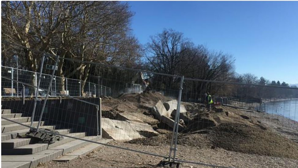
Als erste Maßnahme der Uferrenaturierung in Kressbronn wurde die Ufermauer vor dem Seegarten entfernt. | Bild: Renate Wieland
